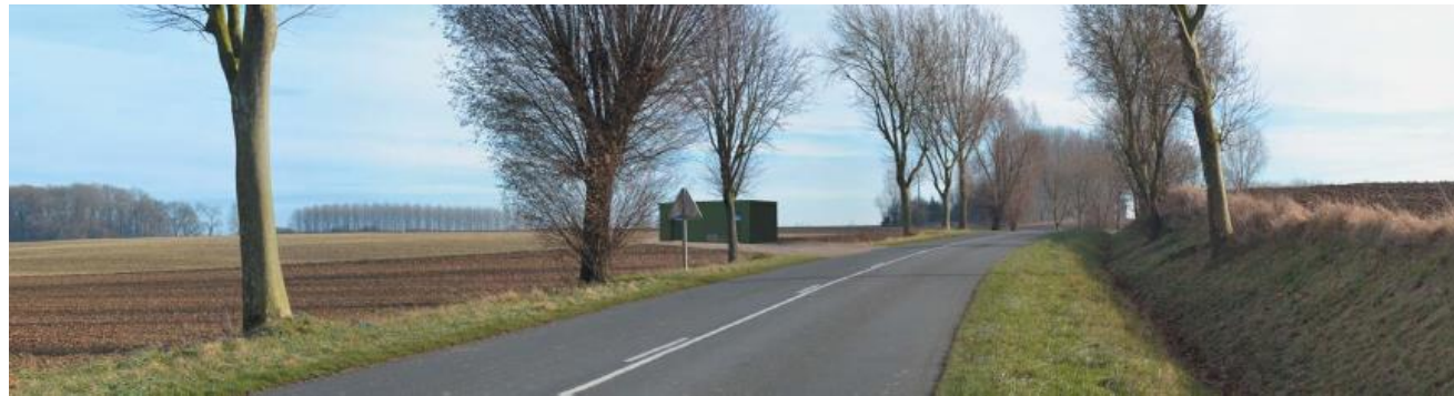
Figure 6 : Insertion du poste de livraison 1 du parc éolien de l'Épinette (source : Laurent Coüasnon, 2016)
